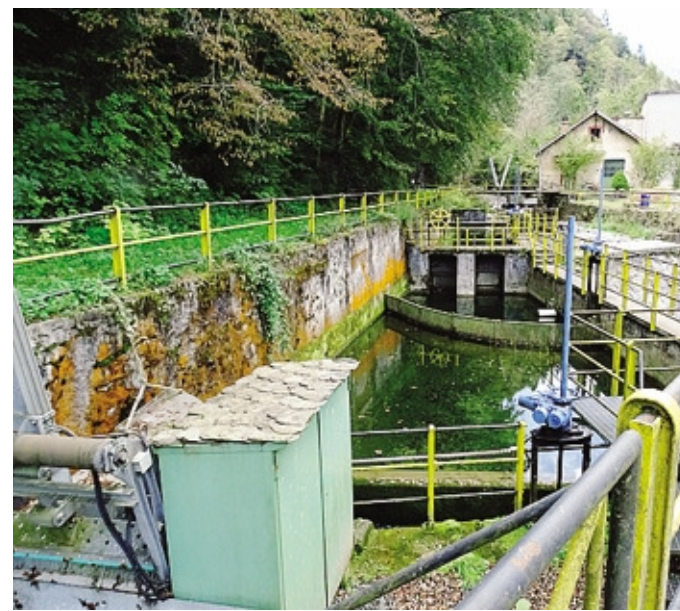
L'opera di presa della centrale idroelettrica sul Riso
